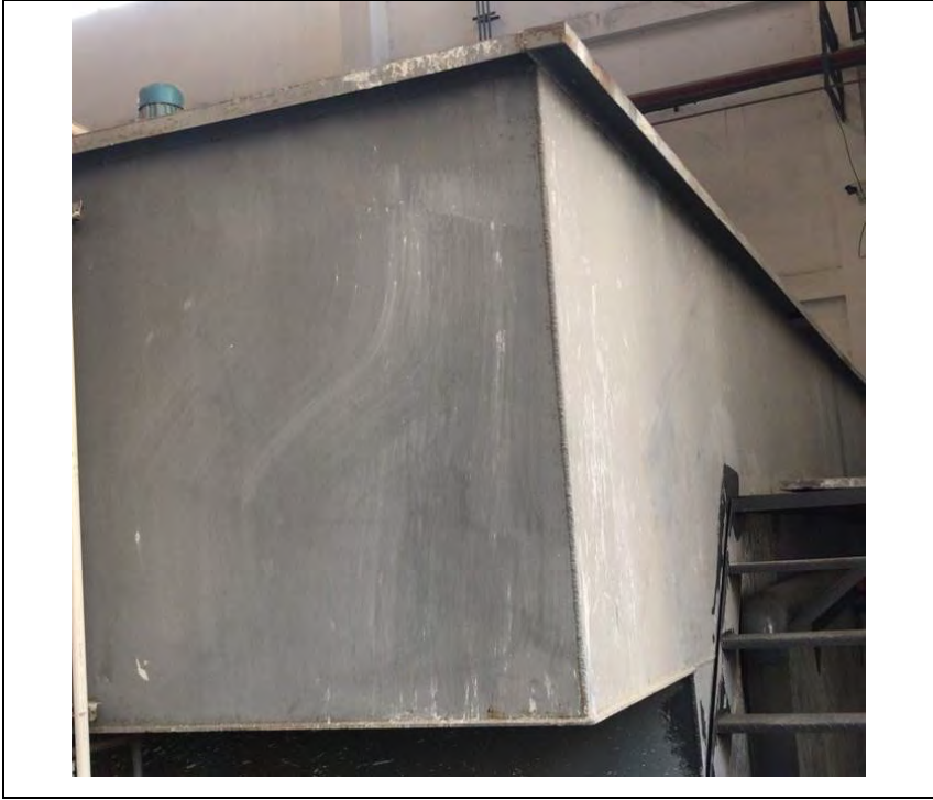
图 4-1 废水处理装置
